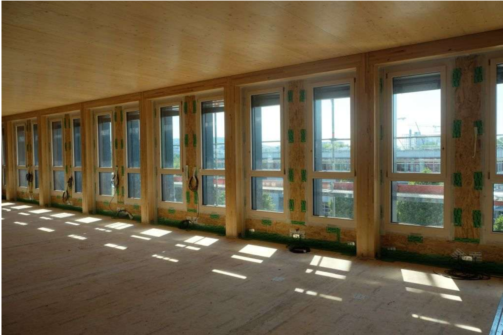
Sechssachsig vorgefertigt: Minimierung von Abdichtungsproblemen
