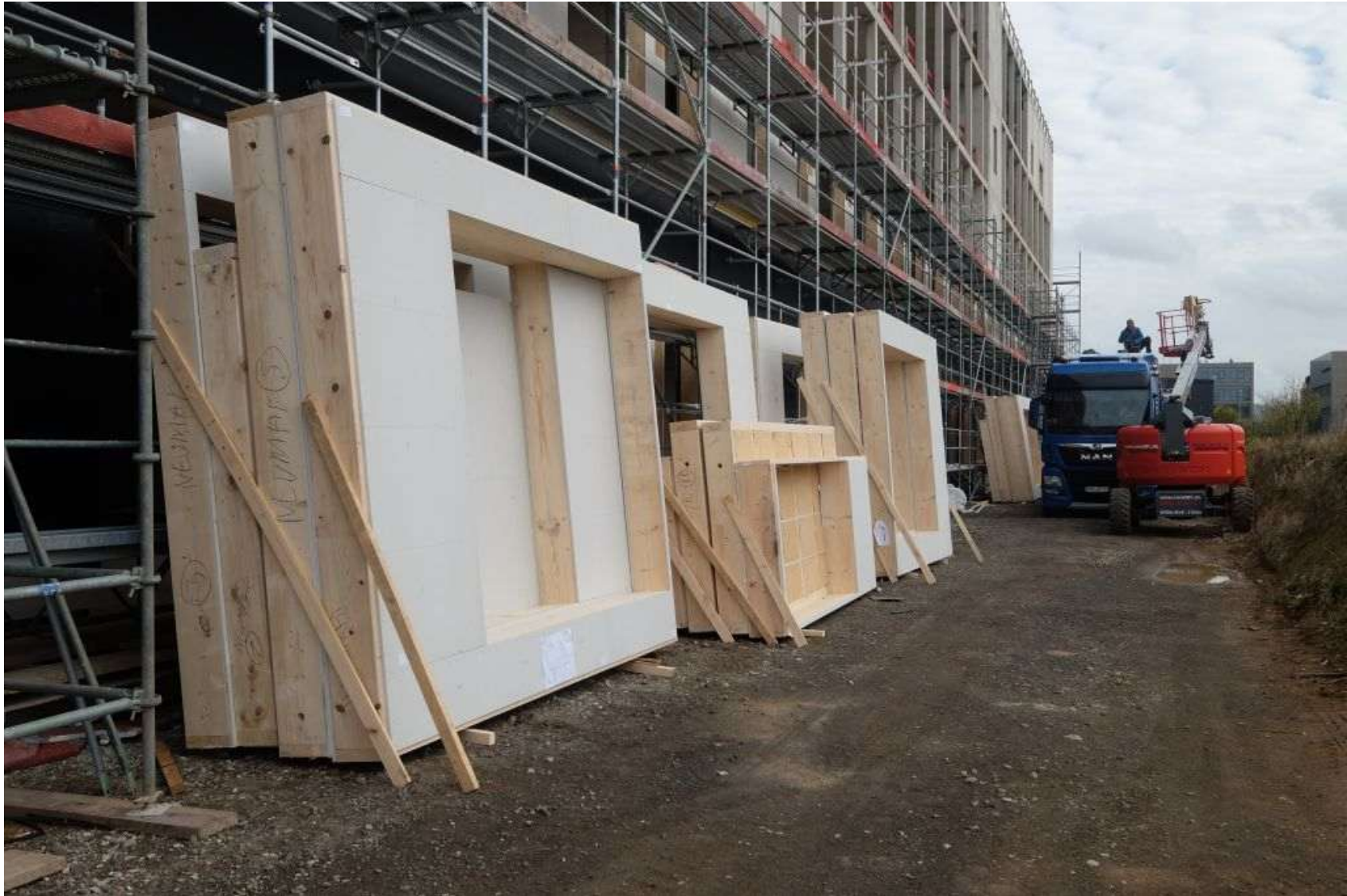
Landesuntersuchungsamt Koblenz: Aufteilung vorgefertigte Fassade in Einzellöcher
