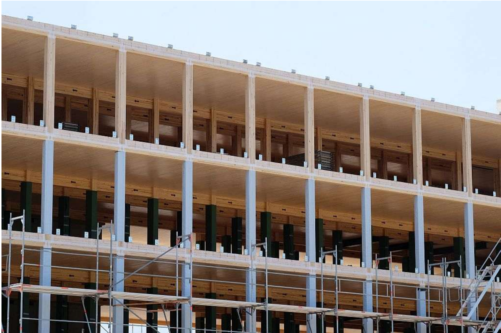
Neubau Kreisverwaltung Mainz-Bingen in Ingelheim: Trennung Konstruktion/Fassade
