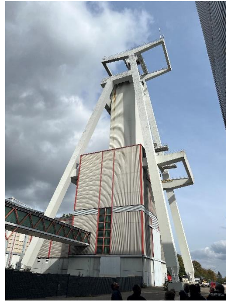
Bitte Foto „Exkursion Göttelborn_1.jpg“ einfügen mit der Bildunterschrift: „Fördergerüst Göttelborn IV“
