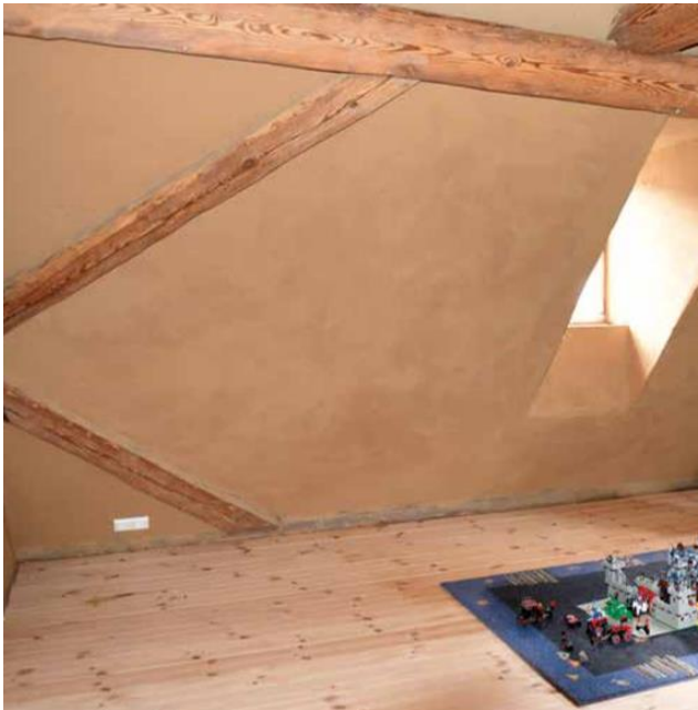
Abbildung 18: Lehmbauplatten verfügen über ein großes Feuchtespeichervermögen, Bildquelle: Lehmix, Hart-Keramik.
