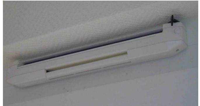
Abbildung 60: ALD als Aufsatzelement in Blendrahmen montiert, Quelle linke Abbildung ift Rosenheim
