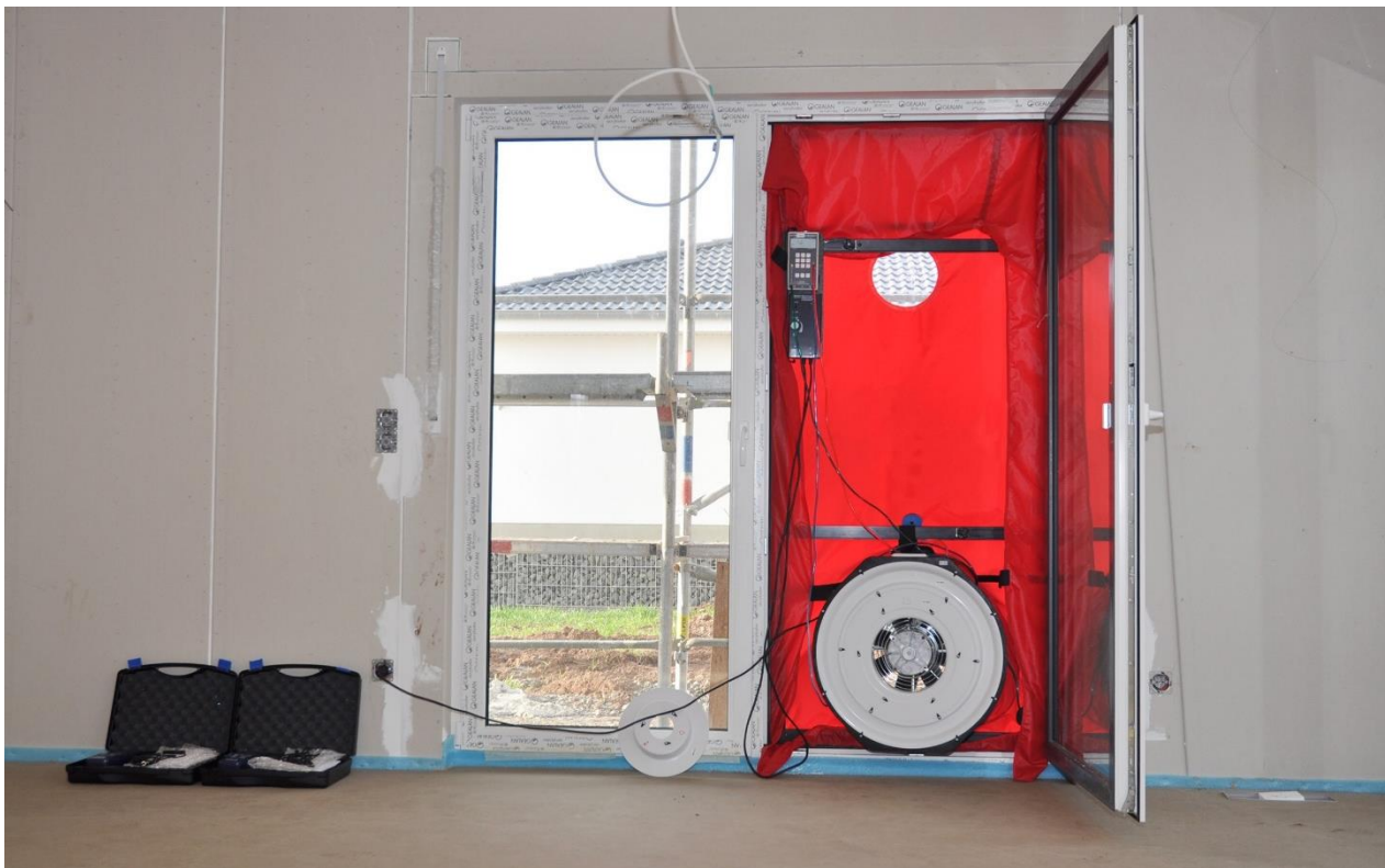
Abbildung 35: Durchführung einer Differenzdruckmessung zur Überprüfung eines n_{50} -Wertes, Fotoquelle FLiB e.V..
