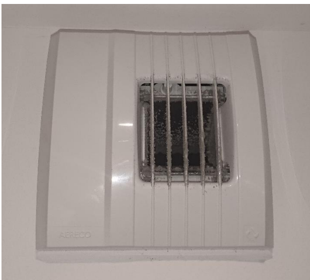
Abbildung 70: Abluftdurchlass einer zentralen Abluftanlage nach 6 Monaten Nutzung – Wartung zweimal jährlich ist je nach Umgebung ratsam
